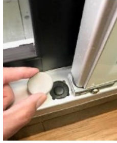
Remove Plug Cap
